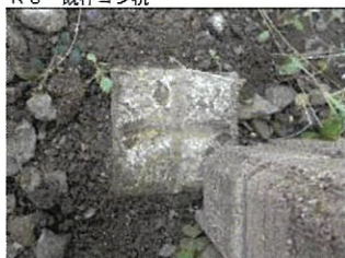
K 3 既存コン杭
