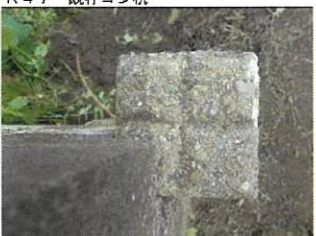
K 4 7 既存コン杭
